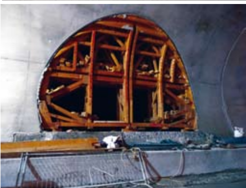
Von oben nach unten: Verschiedene Tunnelabschnitte im Bereich der Nothaltestelle Innsbruck
