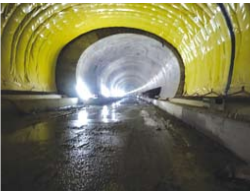
Von oben nach unten: Bohrwagen für Sprenglöcher, Innenausbau, Kunststoffdichtung dahinter Beton-Innenschalen
