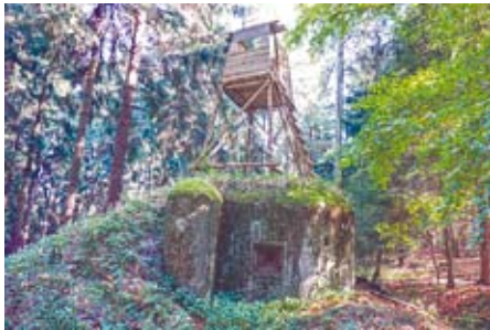
Einer der zahlreichen Bunker an der Schöberlinie
